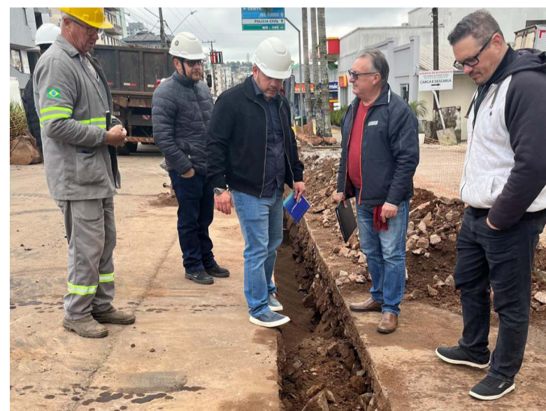
O secretário de Coordenação e Planejamento, Valdenir Cadore, acompanhado do engenheiro civil Fábio Vanzin, realizou uma vistoria técnica nos trechos em obras localizados na Rua João Muniz Reis
